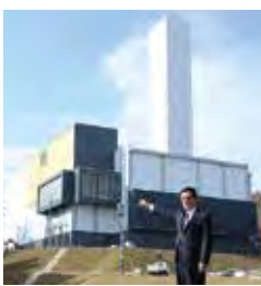
▲毛萱トンネル付近に完成した仙南クリーンセンター
