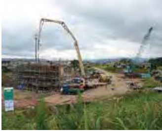
▲写真②:野田排水区雨水ポンプ場の工事の様子です。
