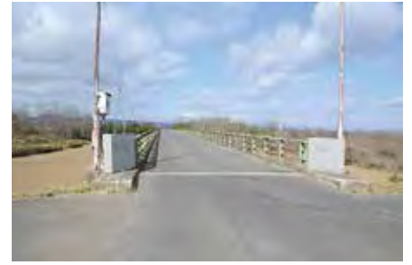
▲枝野橋の安全性と機能を確保するために修繕を実施。
