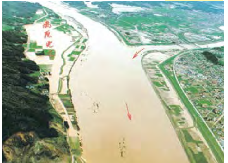
▲台風10号による水害。鳩原地区周辺の浸水状況。（昭和61年8月）写真提供：仙台河川国道事務所
