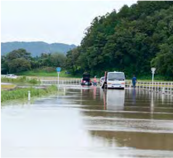
▲関東・東北豪雨で大雨特別警報が発表。国道113号（高倉地区）の浸水状況（平成27年9月）
