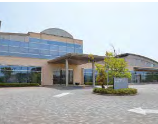
▲総合保健福祉センター（平成14年建築）
