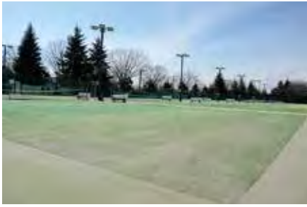
▲劣化しているテニスコートの人工芝の張替改修工事を行います。
