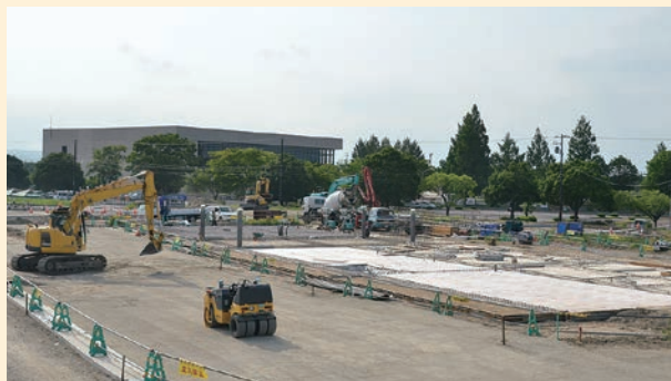
▲建物の基礎工事を行っています（7月25日撮影）
