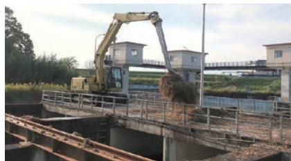
▲除塵設備のシステム不具合により職員が重機でゴミ除去を行っています。
