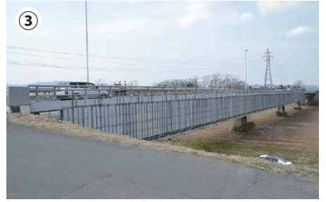
▲安全性の確保を図るために枝野橋の修繕を進めます。
