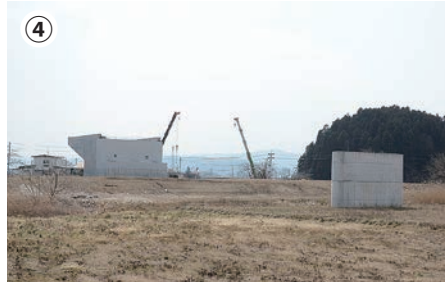
▲歩行者と車両の円滑な通行を確保するために住社橋の整備を進めます。
