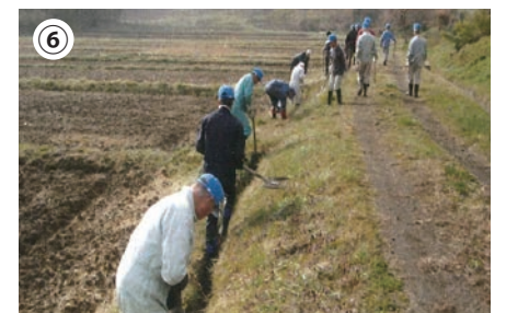
▲多面的機能支払交付金対象団体の浚渫作業です。
