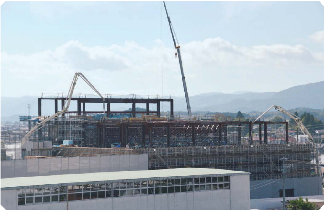
改修工事が進む市民センターホール棟
