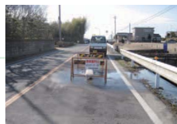
下水道マンホールからあふれる 汚水 (北岡行政区)
