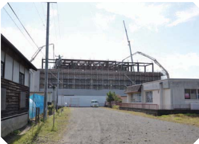
建設中の市民センター
