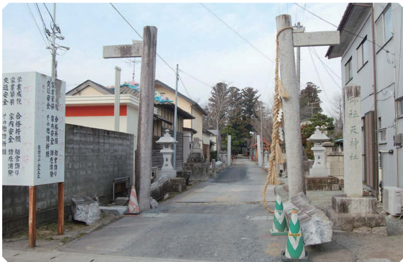
天神社の鳥居上部の倒壊（天神町行政区）
