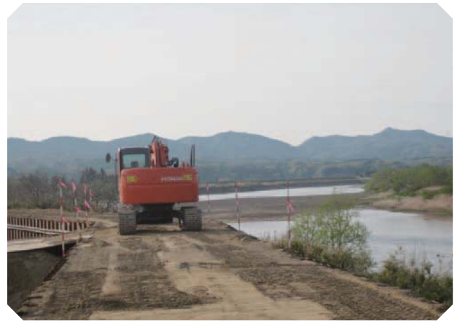
仮の堤防工事（枝野5区行政区）
