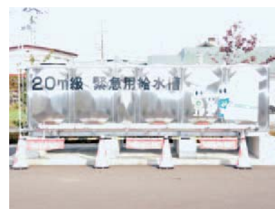
災害時の水を確保する緊急用給水槽 （角田市役所）
