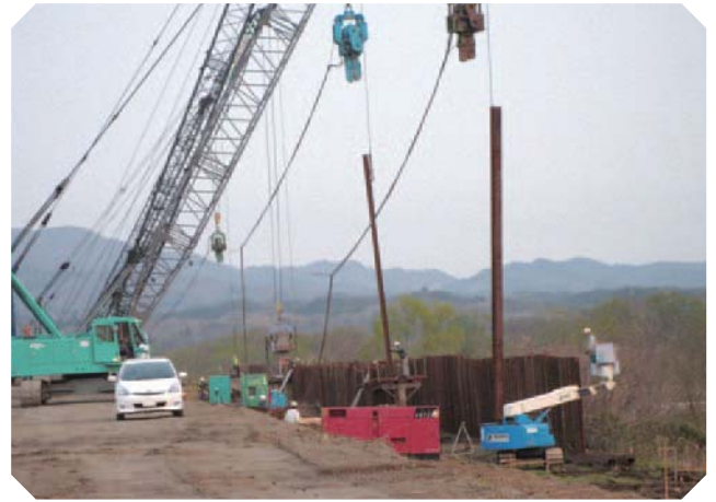
復旧工事（枝野5区行政区）
