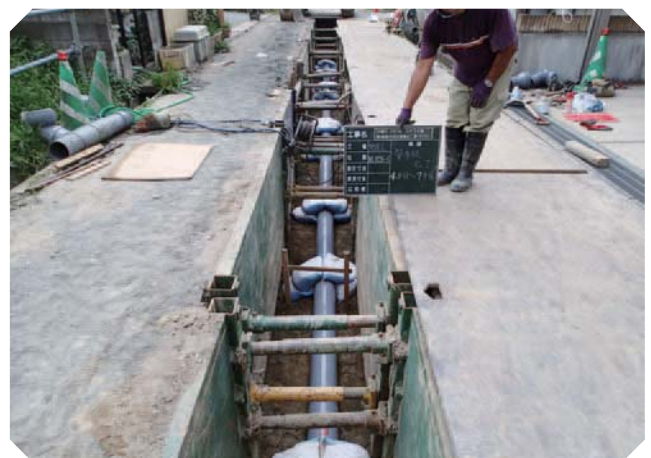
被災した管を新しい管に取り替える工事（谷地町行政区）
