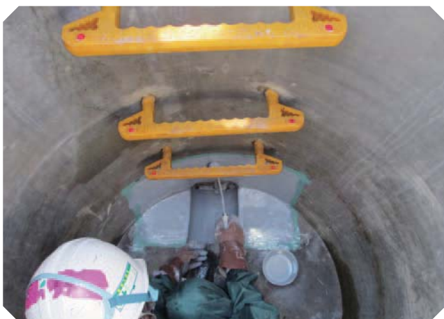
ひび割れしたマンホール内部を補修（谷地町行政区）
