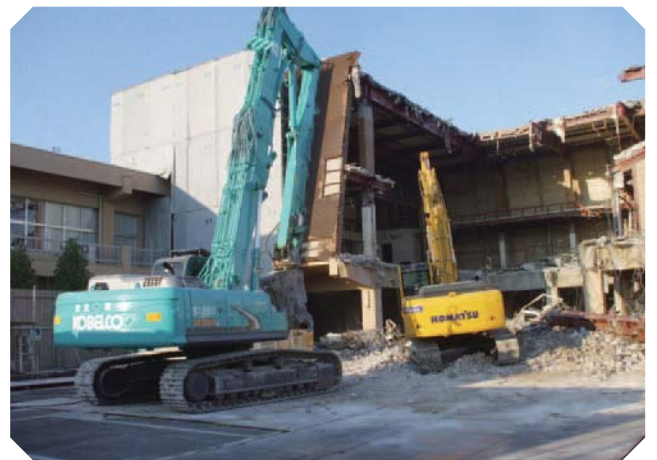
解体される市民センター
