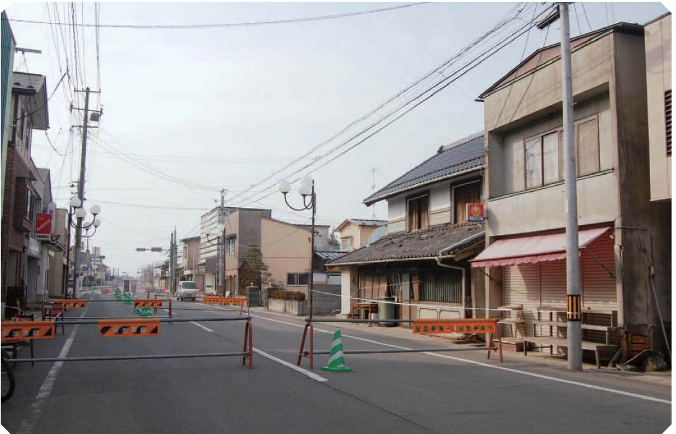
倒壊の恐れのある建物があるため通行止めとなった県道105号線（天神町行政区）
