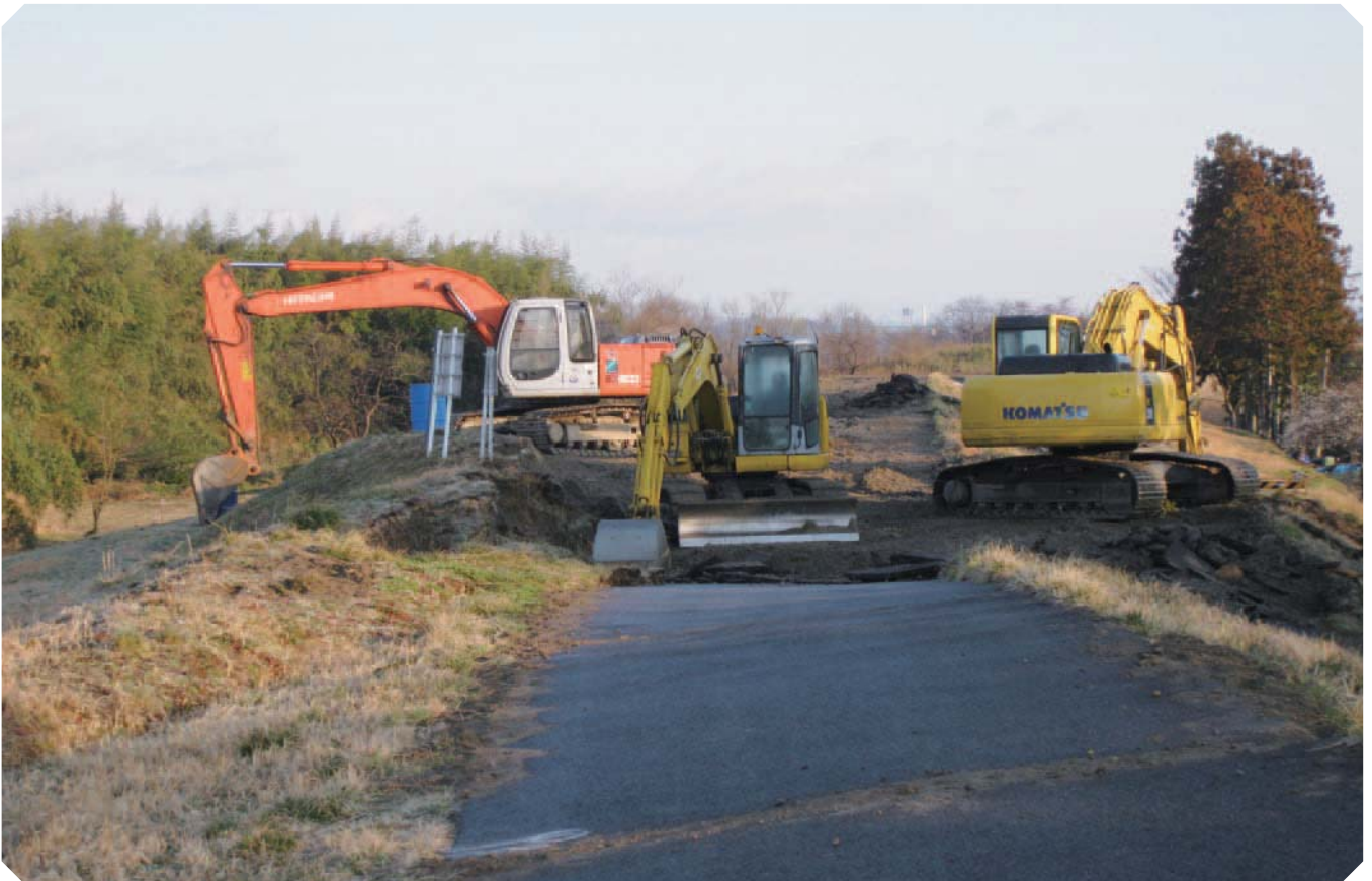
陥没した堤防の復旧工事（枝野5区行政区）
