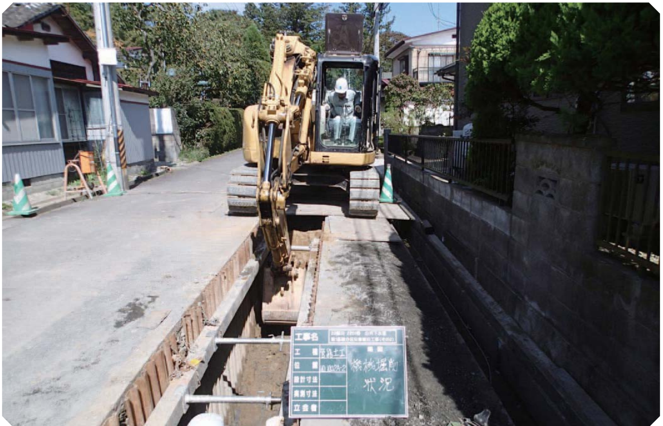
被災した管を取り出すための重機による掘削（谷地町行政区）
