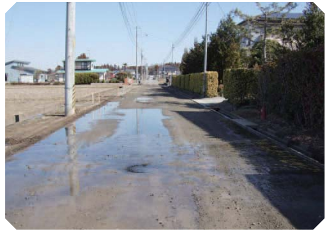
下水マンホールよりあふれる汚水（南江尻行政区）
