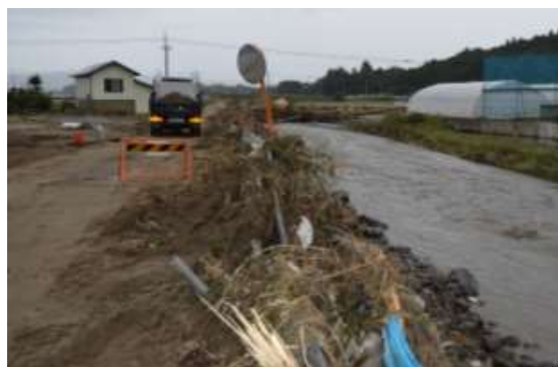
通行止めの状況
