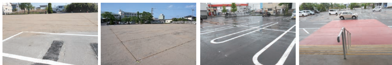
▲区画線設置・防じん舗装▲
