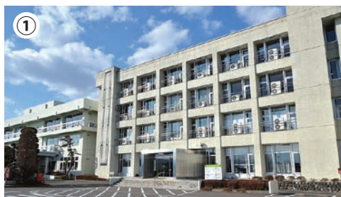
▲市庁舎の耐震補強を実施
