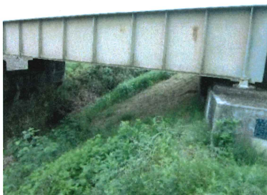
岡地区の洪水状況及び高倉川破堤後（跨線橋橋台部）の復旧写真
