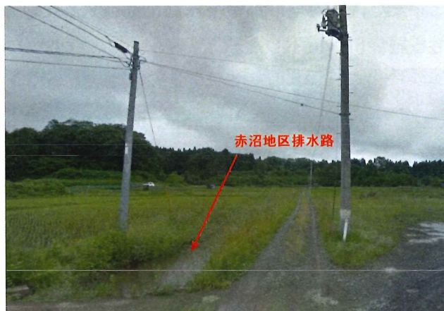
赤沼地区排水路の現況
