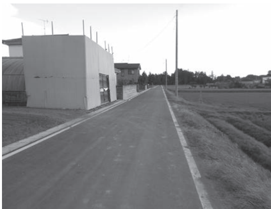
▲北郷地区振興協議会要望事業福田線道路舗装整備（平成30年完了）
