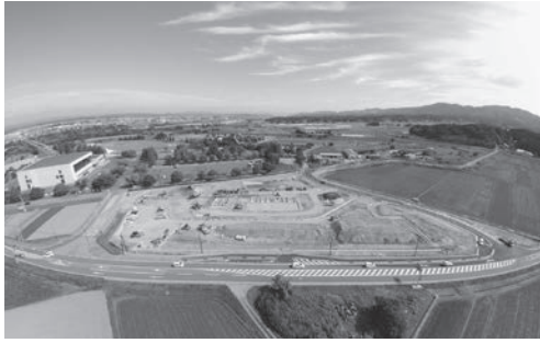
▲整備工事が進む『(仮称)道の駅かくだ』
