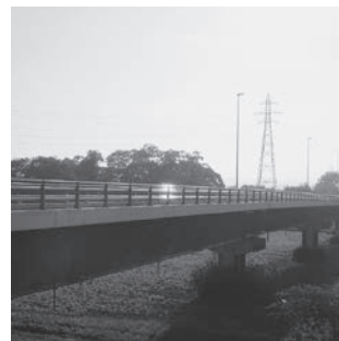
▲改修途中の「枝野橋」
