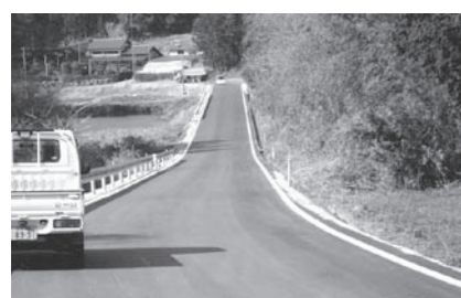
▲補修が完了した市道平口金影沢線の区間
