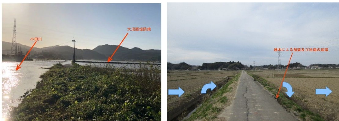
大沼西堤防線の洪水状況及び被災状況
