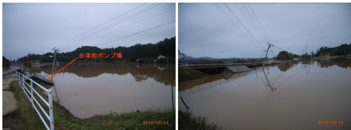
谷津前地区の洪水状況
