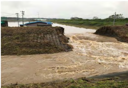
庄司堀川左岸堤防破堤
