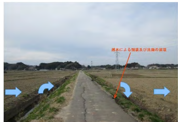
大沼西堤防線の洪水状況及び被災状況
