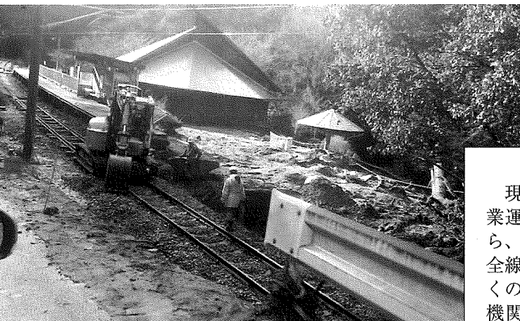
復旧作業（丸森町あぶくま駅付近 令和2年1月撮影）
