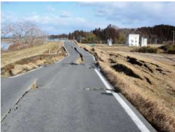
15 ▲激しく損壊した県道丸森柴田線(坂津田中)
