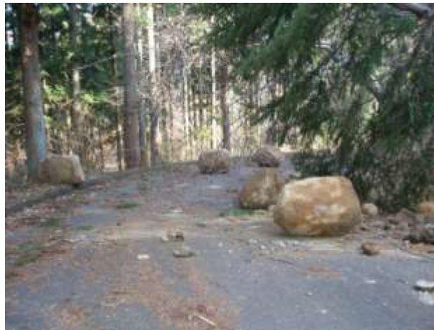
▲林道芋坊線での法面崩壊による落石
