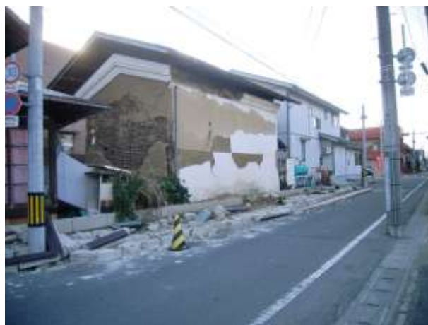
▲市内各所で壁、瓦などに大きな被害(東仲町)
