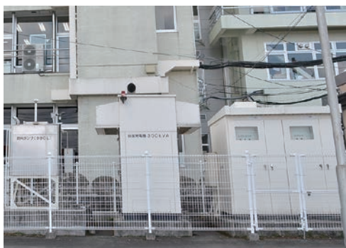
▶有事に備えた改修を実施
