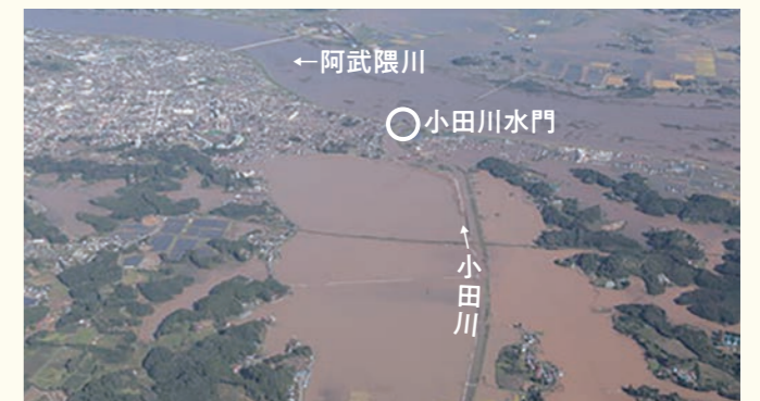
▲令和元年東日本台風で氾濫した小田川の様子
