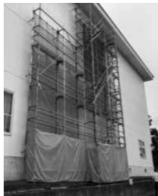
▲整備前の安全対策(桜小屋内運動場)
