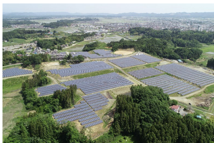
市内の太陽光発電所
