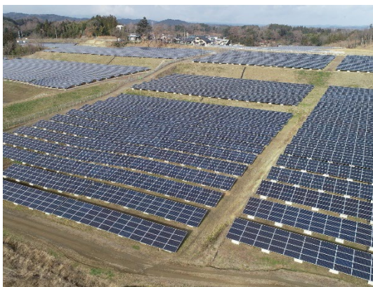
市内の太陽光発電所
