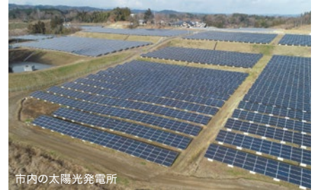
市内の太陽光発電所
