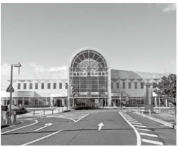
▲角田自治センターの移転先となる角田駅コミュニティプラザ
