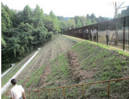
【西根小学校法面改修等工事】
