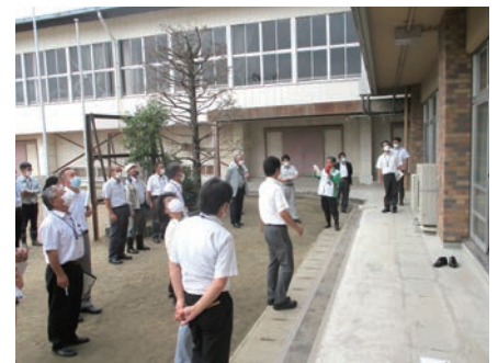
【角田小学校南校舎外壁補修工事】
