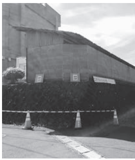
▲解体予定の倉庫
