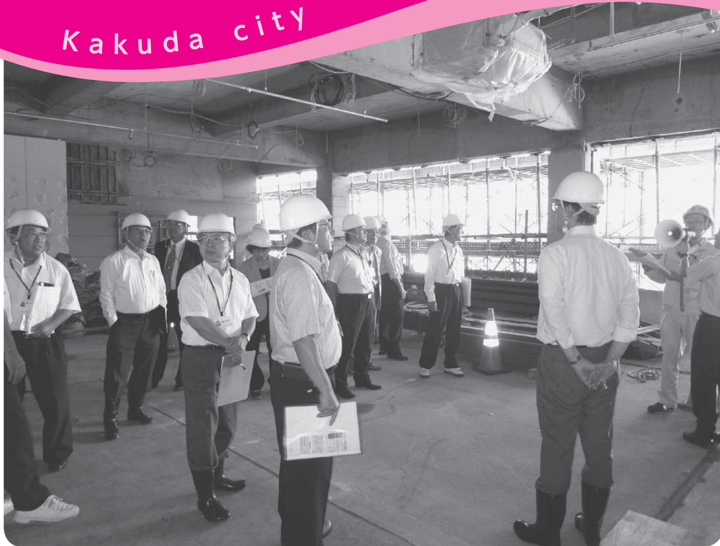
▲決算審査特別委員会による現地調査のようす（平成26年9月12日 市民センター研修棟耐震改修工事）
