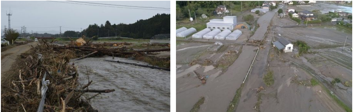
黒内地内の洪水状況
