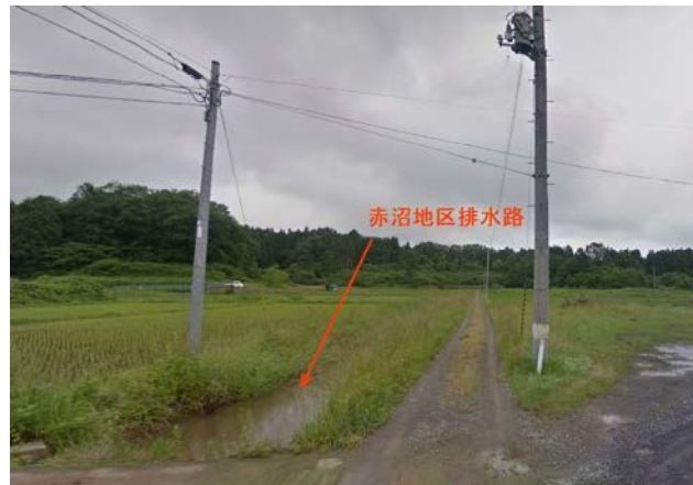
赤沼地区排水路の現況
